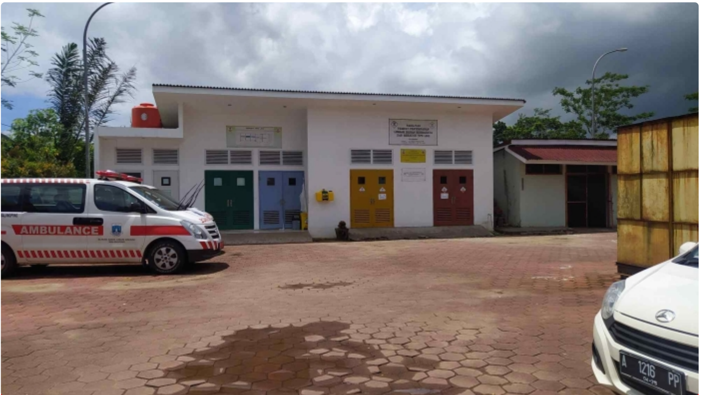
Ruang/gedung instalasi TPSL B3 RSUD Malingping
