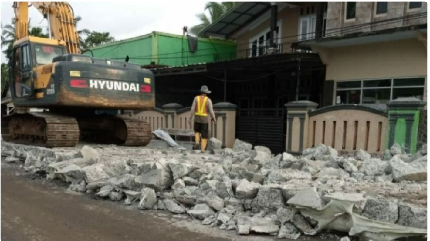
Pembangunan Cor Beton Jalan nasional Simpang-Bayah dibongkar
